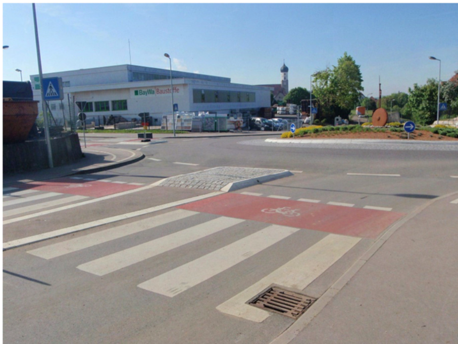
Für den Radverkehr markierte Querungsfurten am Kreisverkehr Altsteußlinger Straße
