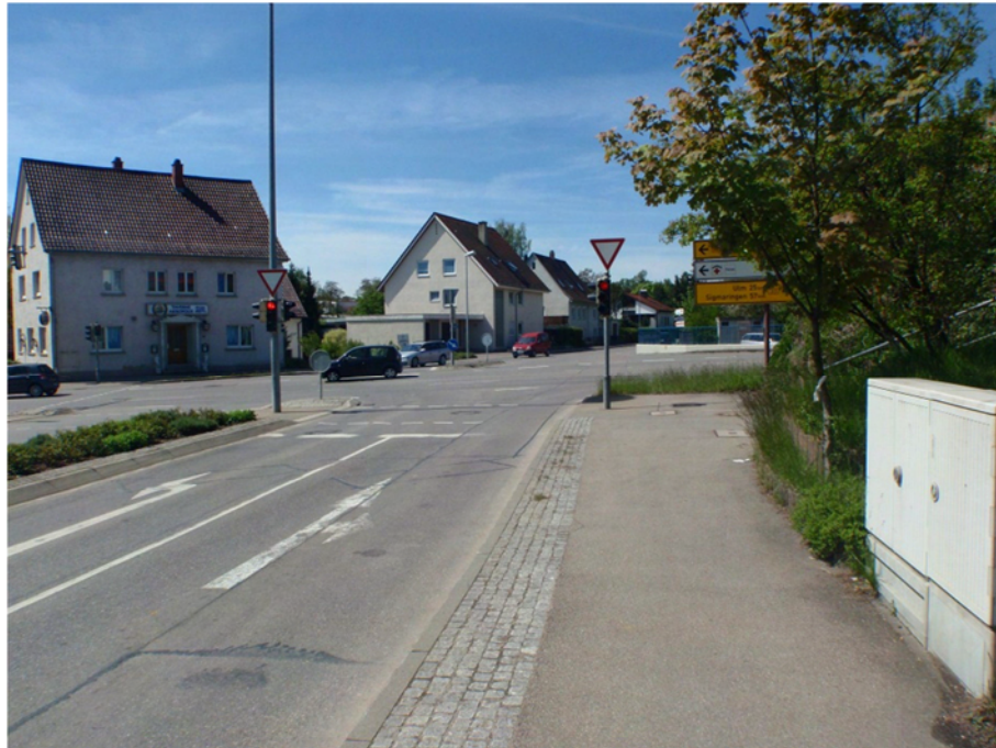
Fehlende Führung des Radverkehrs an signalisierten Knotenpunkten (Alamannenstraße / Riedlinger Straße)
