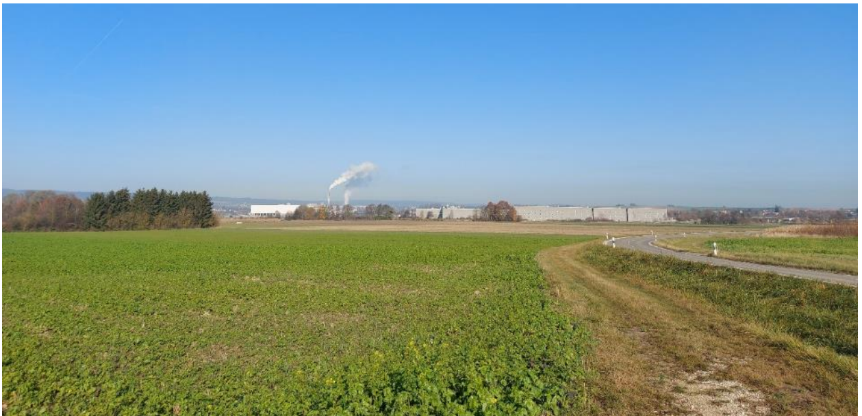
Abb.23: Blick von Süden auf das Logistikzentrum Ehingen
