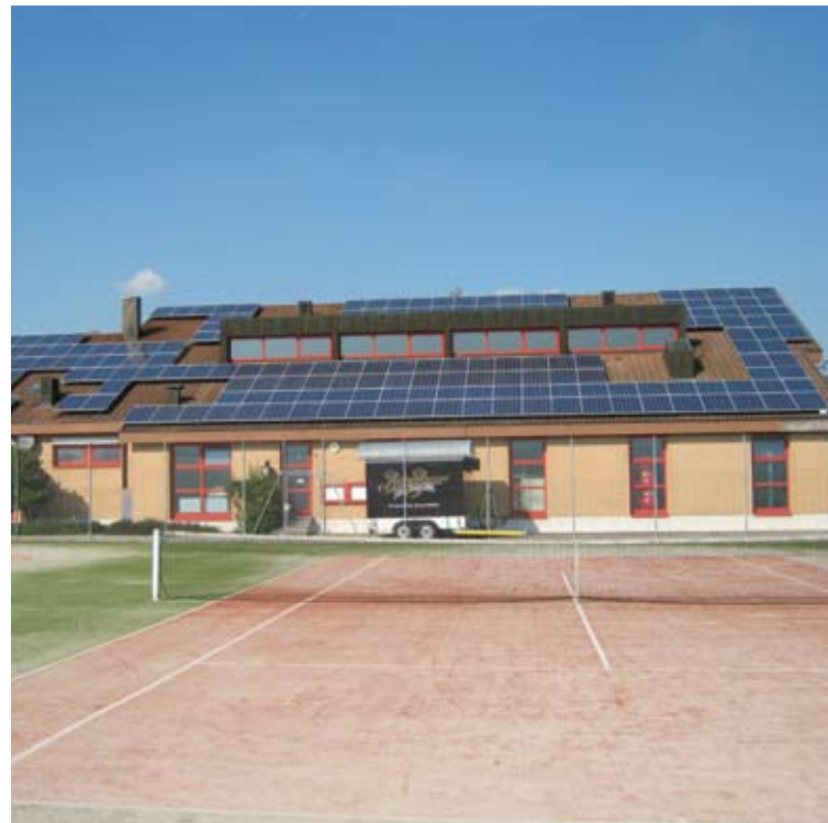
Solaranlage auf der Albhalle in Granheim.
