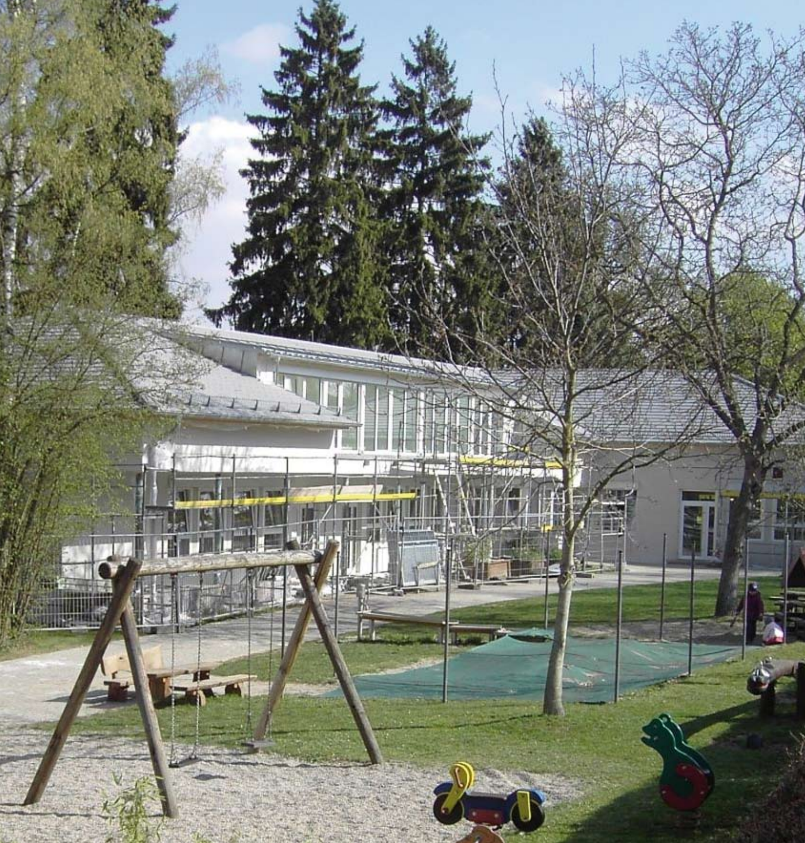
Bis in den Sommer wurde an der energetischen Sanierung des Kindergartens Hehlestraße gearbeitet.
