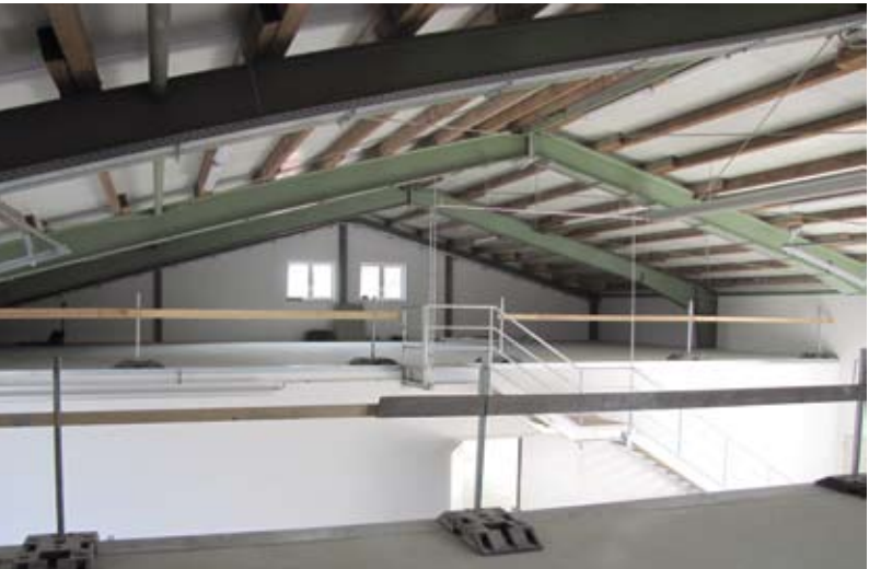
Die neue Bauhofhalle.
