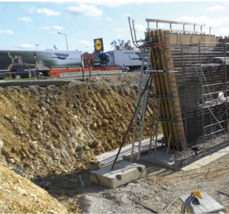
Brückenpfeiler für die neue Münsinger Straße.
