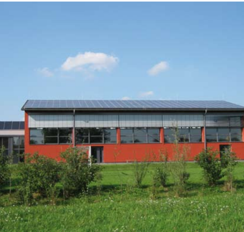
Photovoltaikanlage auf der neuen Sporthalle in Berg.
