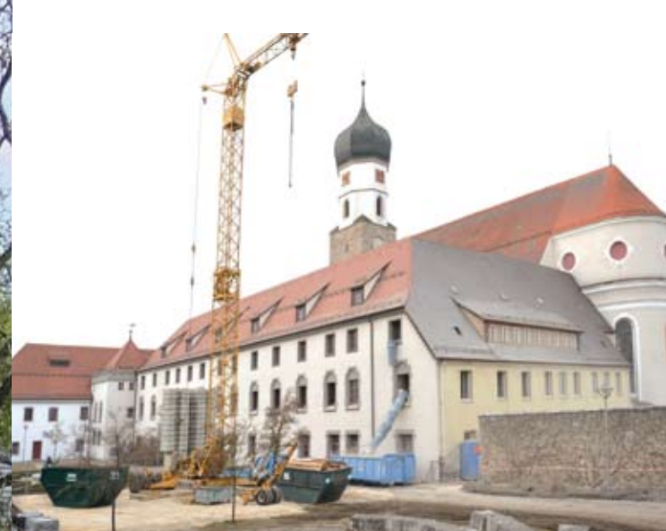
Der Ostflügel des Franziskanerklosters wird saniert.
