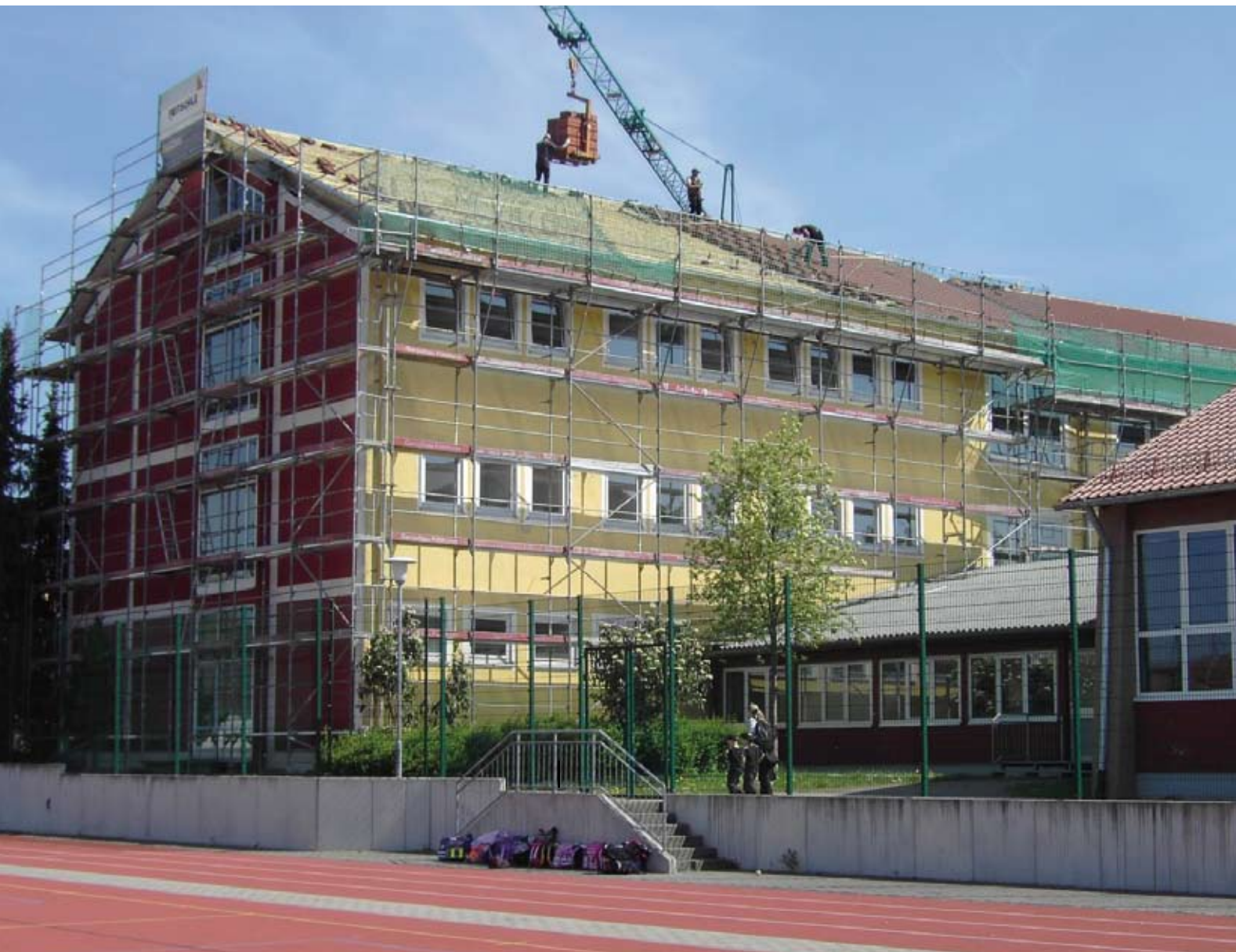
Die Michel-Buck-Schule bekam ein neues Dach.
