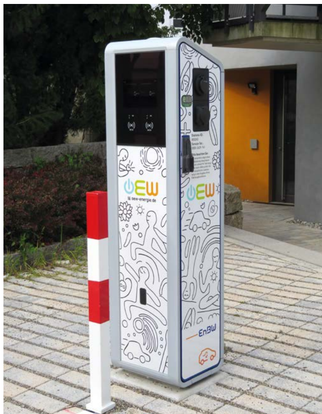
Die bereits installierte OEW-Säule in der Gymnasiumstraße.
